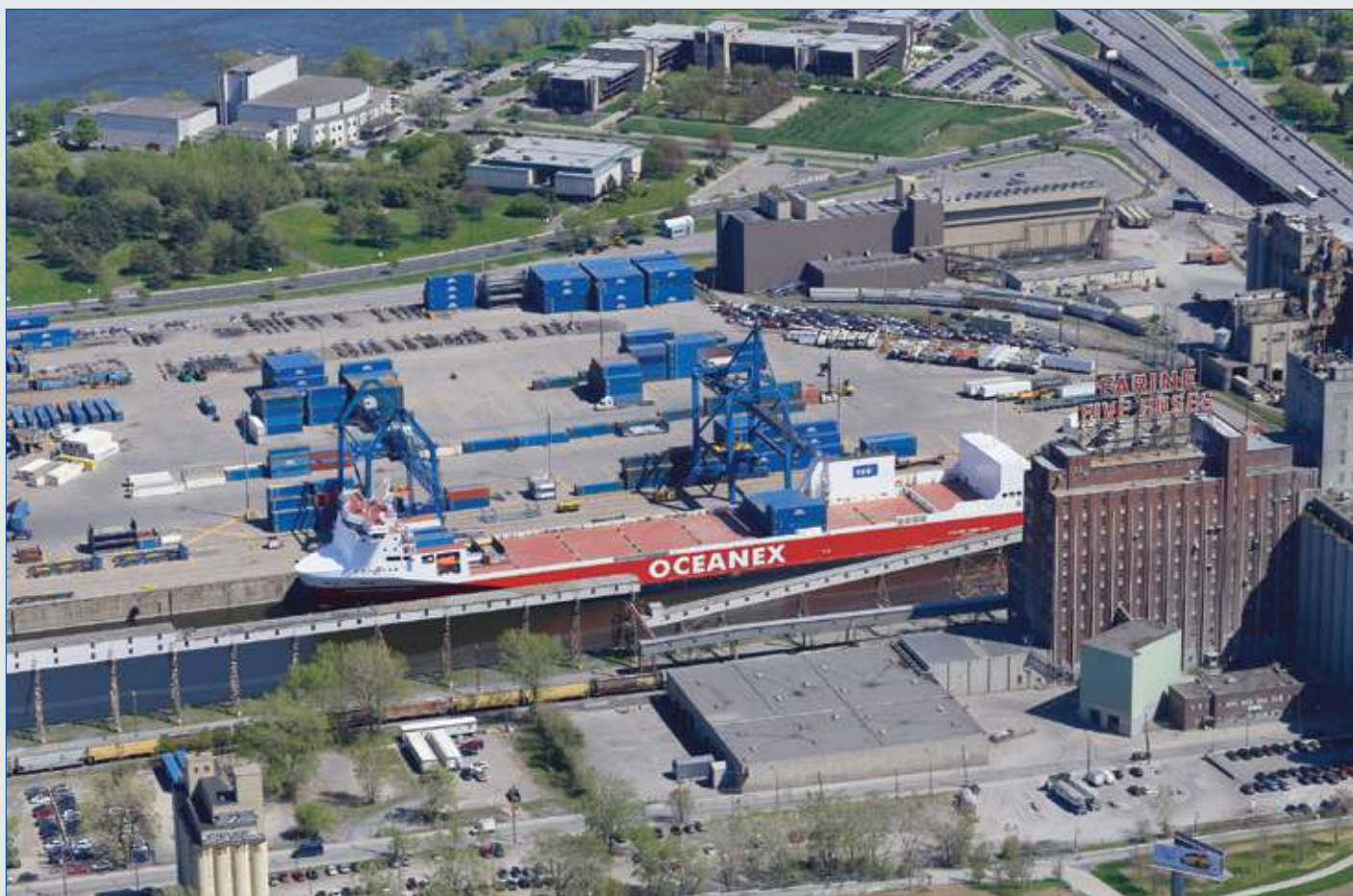
Des travaux d'amélioration et de modernisation sont en cours au terminal Bickerdike exploité par Arrimage Empire.
